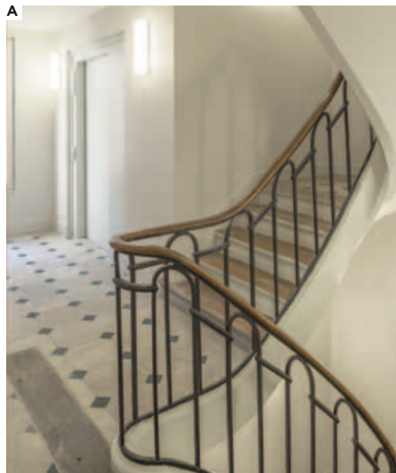
A Un ascenseur n'a pu être installé qu'en supprimant un escalier secondaire (rue Saint-Honoré, Paris 1 er ).
